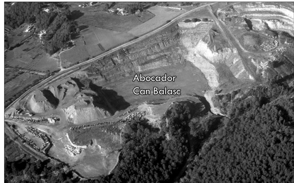
Gran forat de més de 20 m de profunditat corresponent a l'extractiva de Can Balasc, a on va el nou abocador. Foto MR
